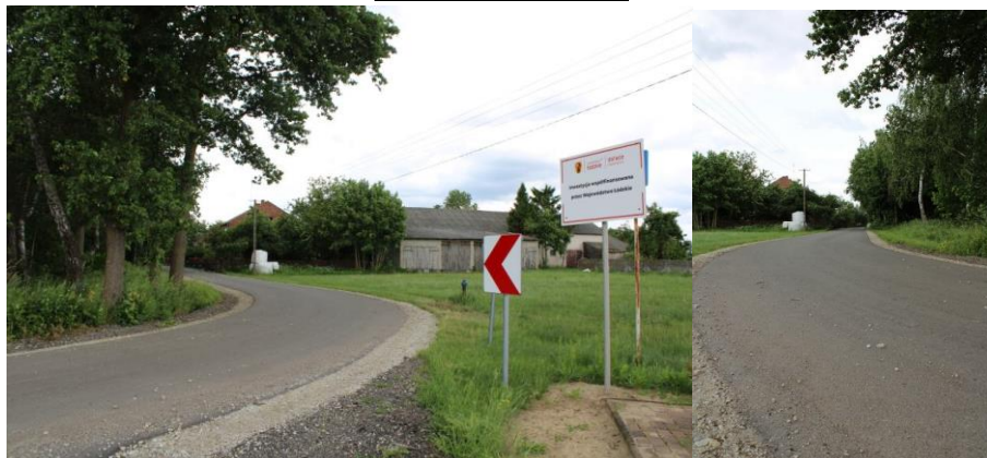
REMONT ODCINKA DROGI GMINNEJ NR 117310E, UL. CMENTARNA W RADOSZEWICACH
